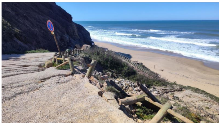
Imagem 1 – identificação de alteração de massa e deposição de detritos e blocos na situação de instabilidade
