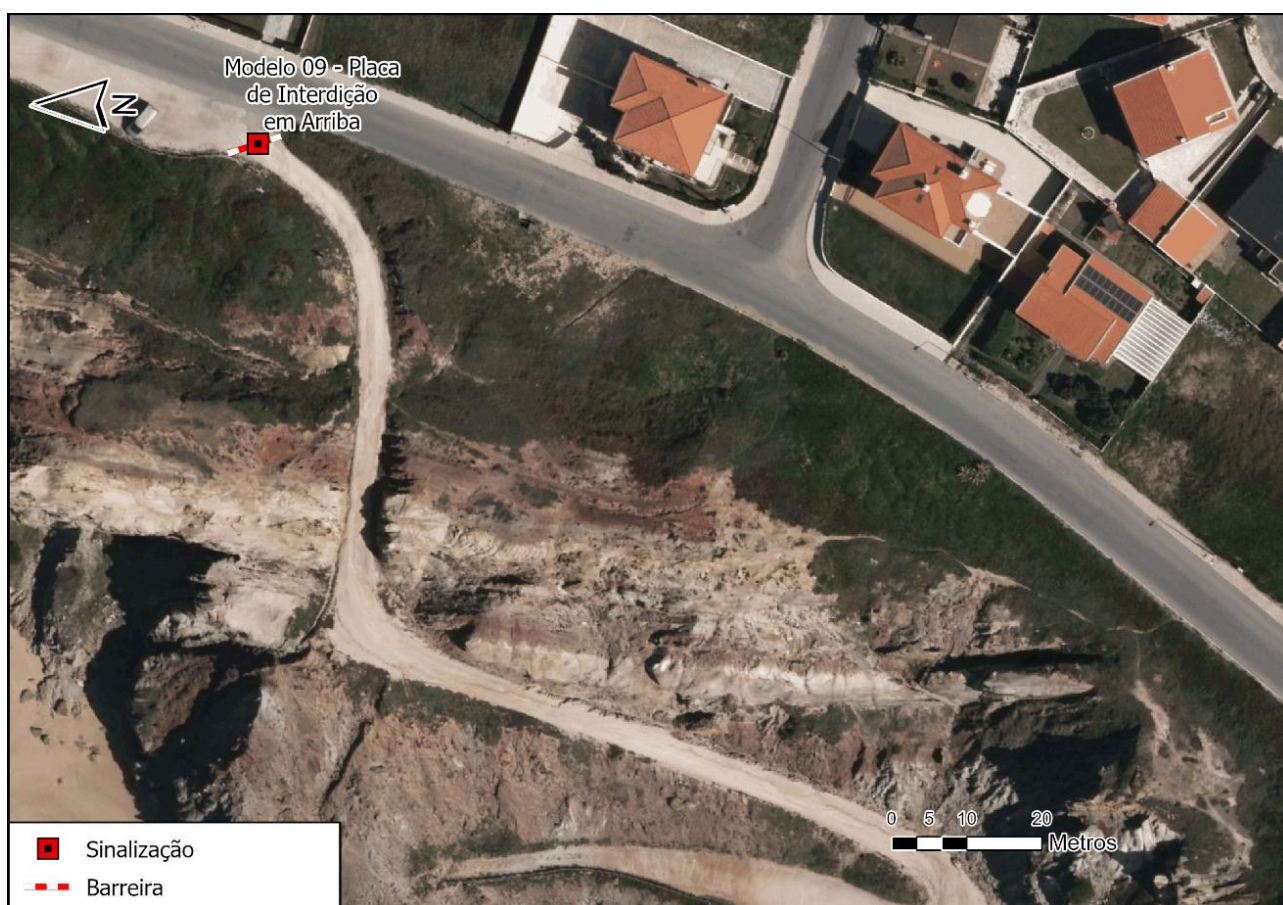
Imagem 3 – Zona de interdição de acesso à praia da Amoeira – Torres Vedras
